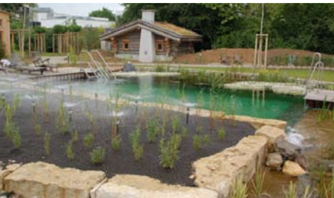
Ausgelagerte Filterkörper (hier beregnete Filter) machen den Natur-Pool belastbarer und sorgen für eine stabile Wasserqualität.
