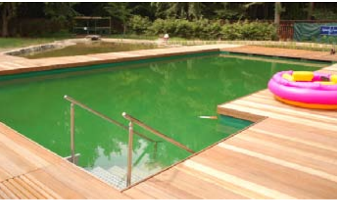
Natur-Pool mit komplett ausgelagerten Regenerationsbereichen (Typ V)
