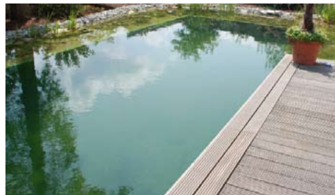
Einkammersystem in Beckenbauweise. Der Aufbereitungsbereich ist gezielt durchströmmt (Typ III, mit Pool-Charakter)
